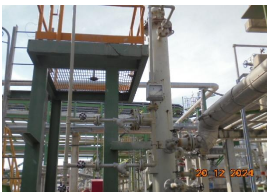
รูปที่ 3-13 อุปกรณ์ตรวจวัดอัตราการไหล ของน้ำที่เข้าสู่ Scrubber
