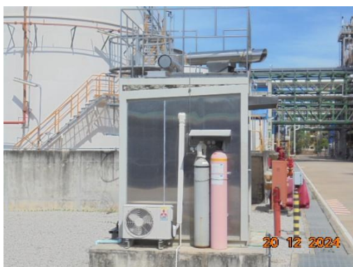
รูปที่ 3-73 Open Path Gas Detection
