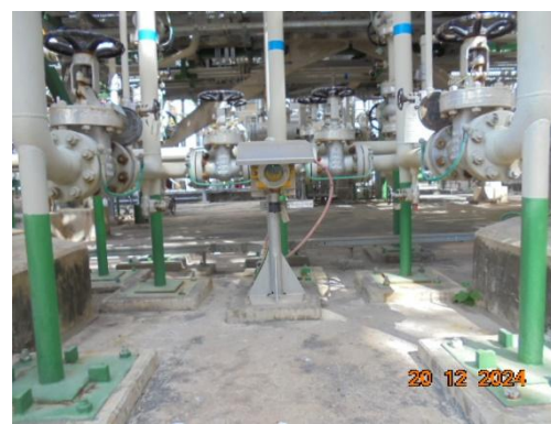
รูปที่ 3-14 Gas Detector
