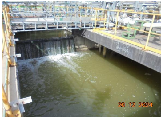
รูปที่ 3-28 บ่อพักน้ำทิ้ง (Final Polishing Pond : TK-9141)
