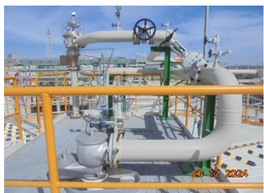
รูปที่ 3-65 วาล์วนิรภัยที่ดักเก็บกักสารเคมี
