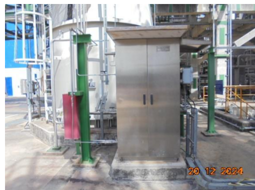
รูปที่ 3-8 เครื่องตรวจวัดสารประกอบ ไฮโดรคาร์บอนแบบต่อเนื่อง ที่ปล่อง Charcoal Adsorber 6
