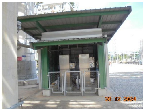
รูปที่ 3-7 เครื่องตรวจวัดเบนซินแบบต่อเนื่อง ที่ปล่อง Charcoal Adsorber 2
