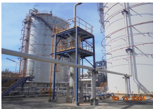
รูปที่ 3-11 ระบบดักจับไอระเหยด้วยน้ำ (Acetone Wet Scrubber) ของถังเก็บสารอะซิโตน (TK-4163A/B)
