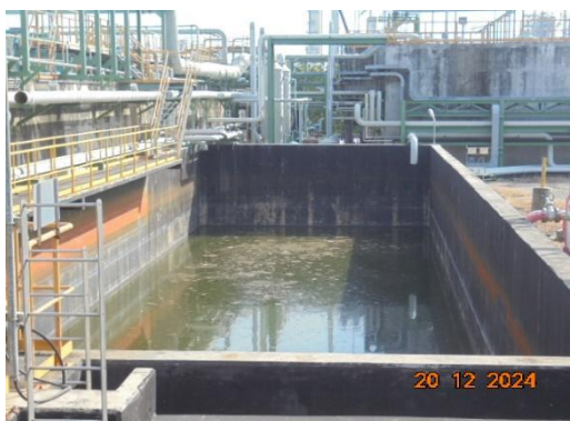
รูปที่ 3-34 บ่อพักน้ำทิ้งถูกเดิน (Diversion Basin : TK-9142A/B)
