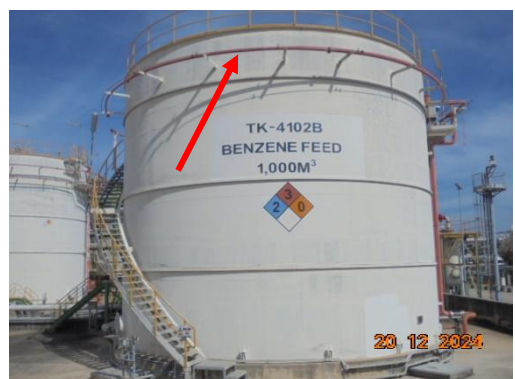
รูปที่ 3-78 ระบบ Water Spray ที่ถังเก็บสารเคมี
