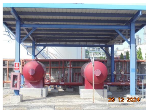
รูปที่ 3-79 ระบบดับเพลิงบริเวณถังเก็บกักอะซิโตน
