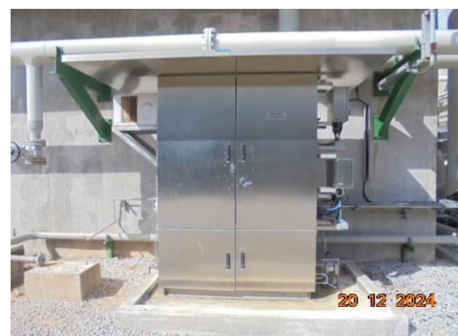
รูปที่ 3-37 เครื่องตรวจวัด COD แบบอัตโนมัติ ที่ Final Polishing Buffer Tank (TK-9145)
