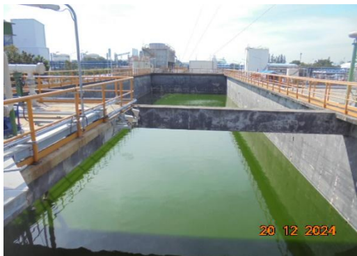
รูปที่ 3-32 บ่อพักน้ำฝนปนเปื้อน
