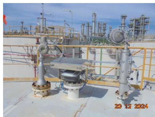
รูปที่ 3-75 Pressure/Vacuum Vent Valve
