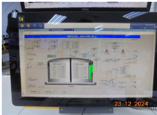
รูปที่ 3-76 ระบบแจ้งเตือนระดับสารเคมี ภายในถังเก็บกักไปยังห้องควบคุมส่วนกลาง
