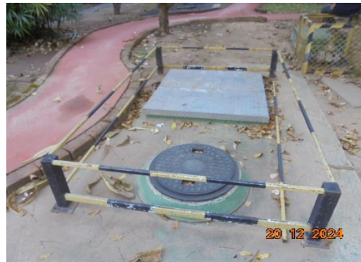
รูปที่ 3-39 ระบบบำบัดน้ำเสียสำเร็จรูป
