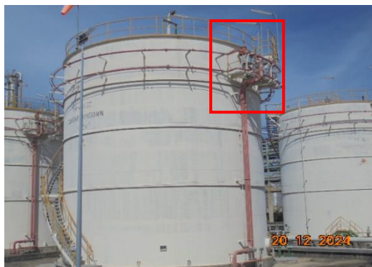
รูปที่ 3-70 ระบบโพนของถังเก็บกักสารเคมี
